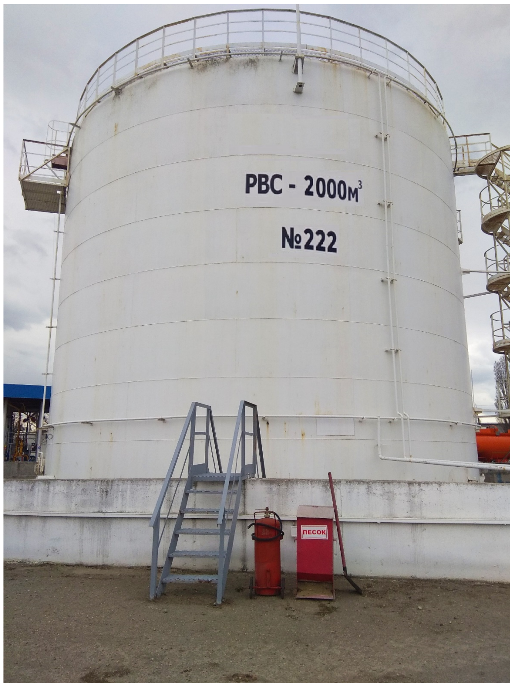
Рисунок 1 – Фотография общего вида резервуара вертикального стального цилиндрического РВС-2000 заводской номер 222
