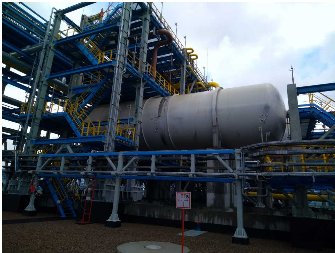
Рисунок 2 – Общий вид резервуара РГС-368,5 с зав.№ 17С08
