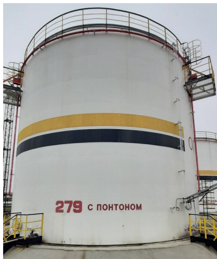
Рисунок 2 – Общий вид резервуара РВСП-2000 №279
