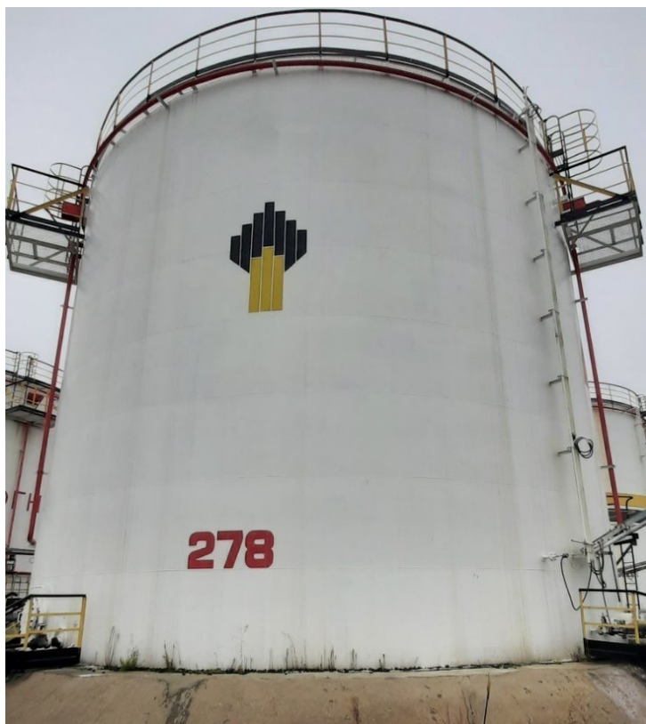
Рисунок 1 – Общий вид резервуара РВСП-2000 №278
