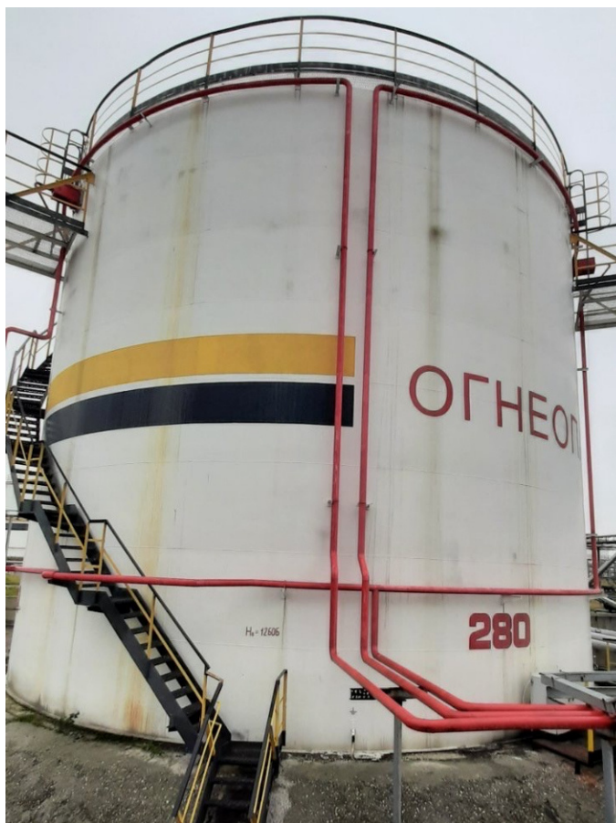
Рисунок 3 – Общий вид резервуара РВСП-2000 №280
