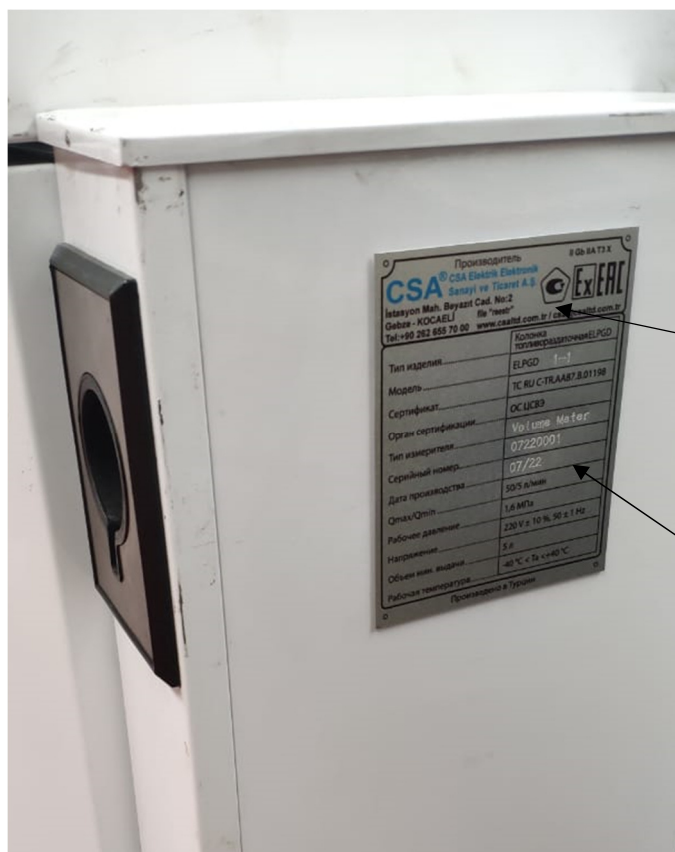
Рисунок 2 – Место нанесения знака утверждения типа, заводского номера
