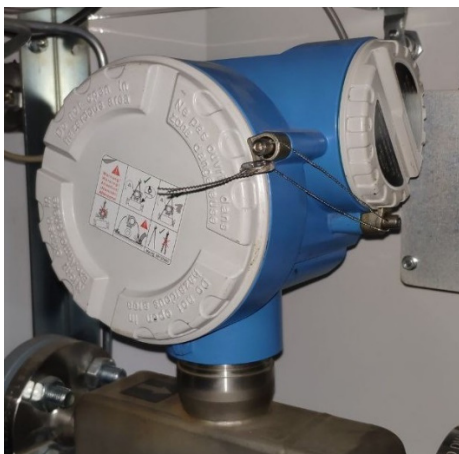
Рисунок 5 - Пломбировка расходомера массового LPGmass
