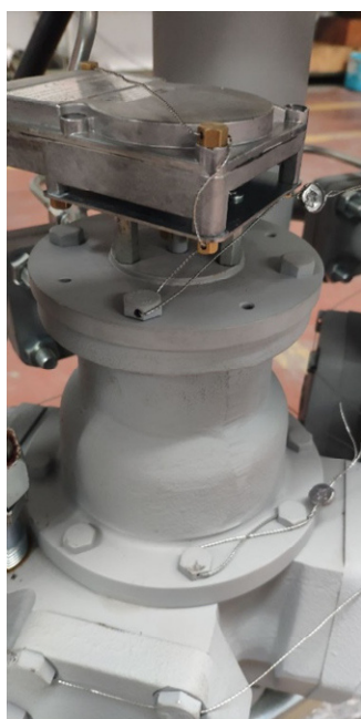
Рисунок 3 - Пломбировка датчика импульсов FBCGQ-3 совместно с измерителем объема LPGFM1
