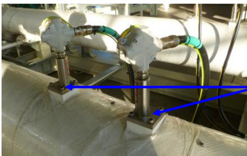
Рисунок 5 – Места пломбирования ТПУ OGSB
