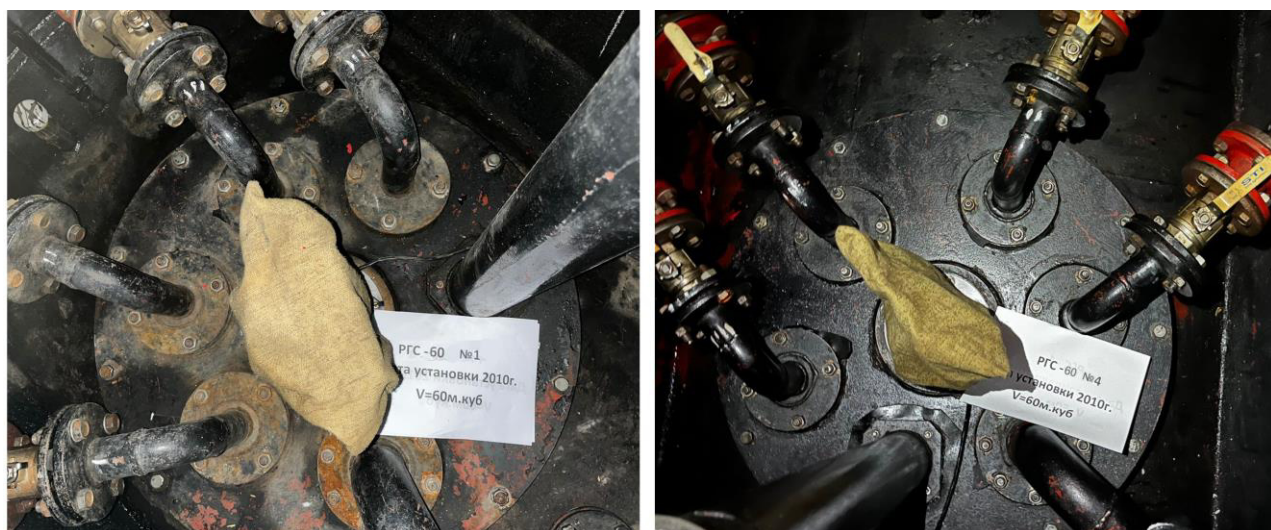
Рисунок 3 – Горловины резервуаров РГС-60 зав.№№1, 4
