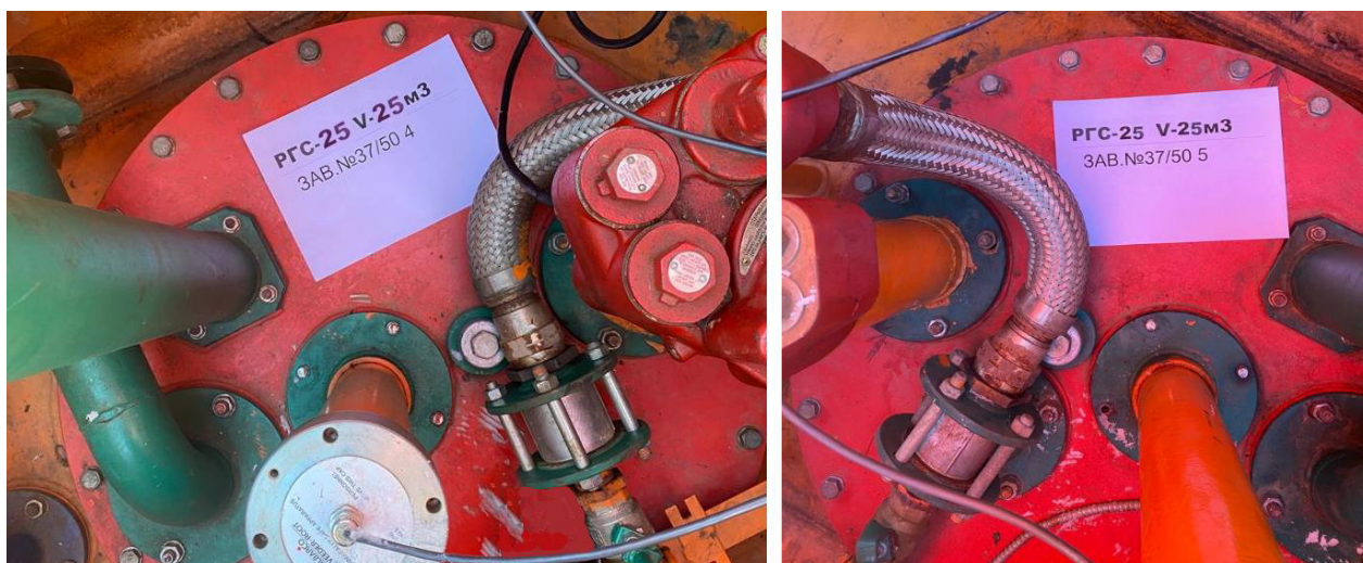
Рисунок 4 – Горловины резервуаров РГС-25 зав.№№ 37/504, 37/505
