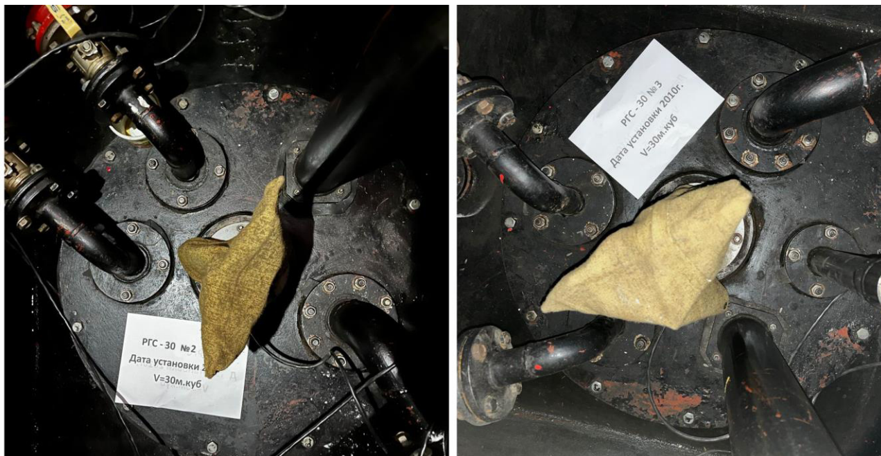
Рисунок 2 – Горловины резервуаров РГС-30 зав.№№2, 3
