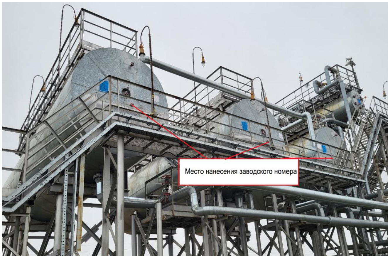
Рисунок 1 - Общий вид резервуаров горизонтальных стальных цилиндрических РГС- 80 с указанием места установки таблички с заводским номером
