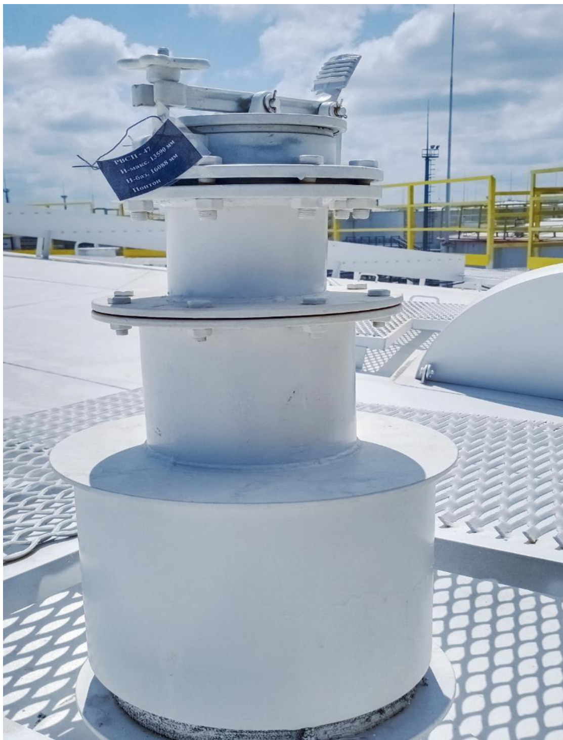
Рисунок 2 - Фотография крышки замерного люка резервуара РВСП-4950 заводской номер 47
