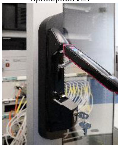
Рисунок 5 – Запирающий механизм стойки
