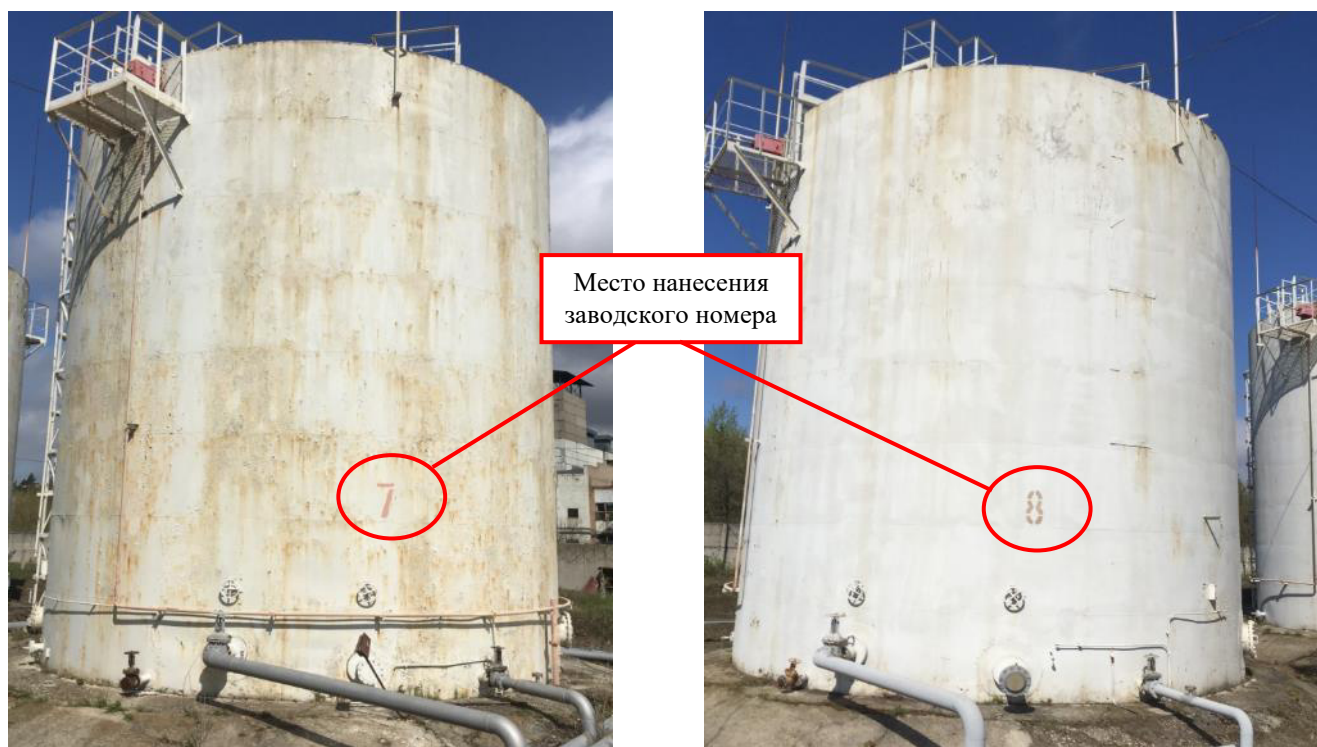
Рисунок 4 – Общий вид резервуара стального вертикального цилиндрического РВС-1000 зав.№ 7, зав.№ 8
