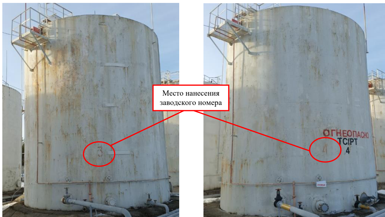
Рисунок 2 – Общий вид резервуаров стальных вертикальных цилиндрических РВС-1000 зав.№ 3, зав.№ 4
