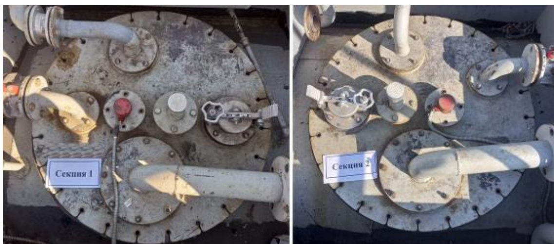
Рисунок 4 – Горловины и измерительные люки резервуара РГ 20/2-П-02-УХЛ1ТУ зав.№ 1638 Пломбирование резервуара РГ 20/2-П-02-УХЛ1ТУ не предусмотрено.
