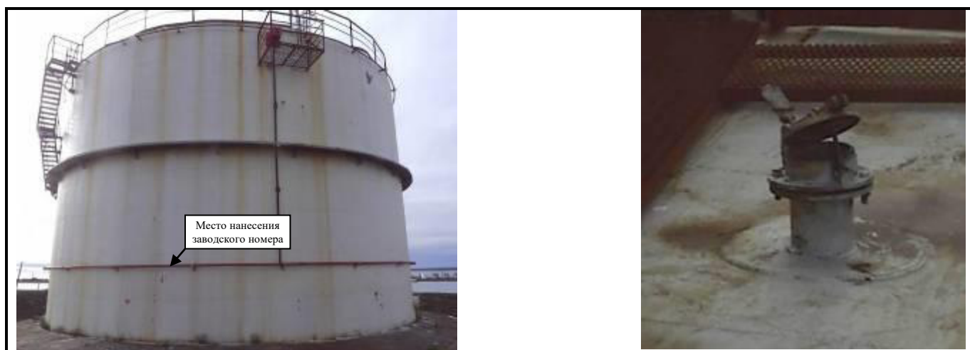
Рисунок 3 – Общий вид резервуара РВС-3000 (№45) с замерным люком
