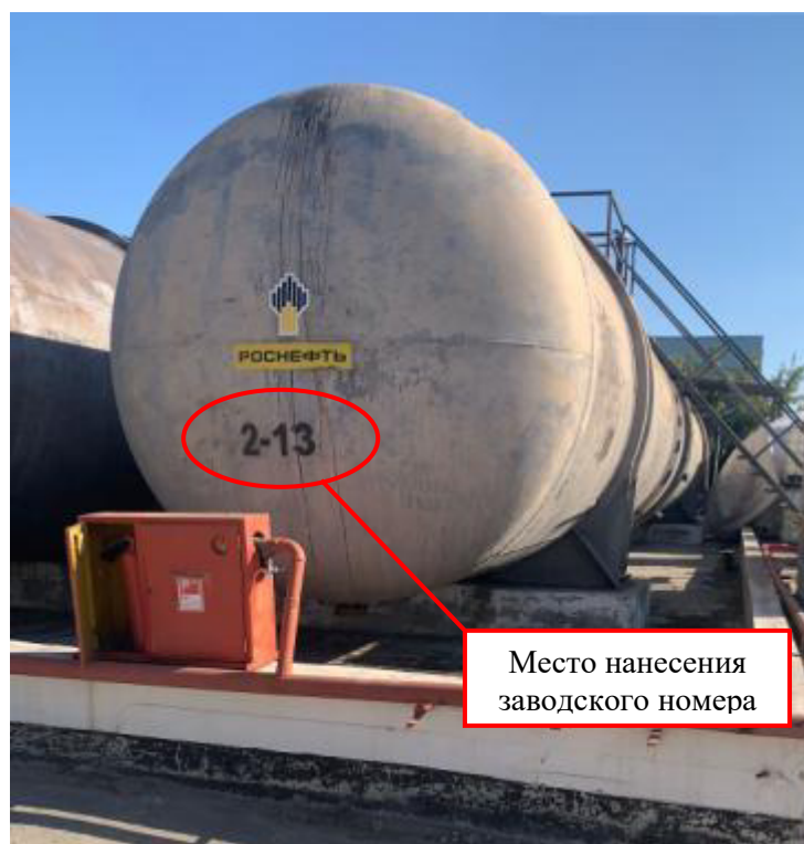
Рисунок 3 – Общий вид резервуара РГС-140 № 2-13 с указанием места нанесения заводского номера
