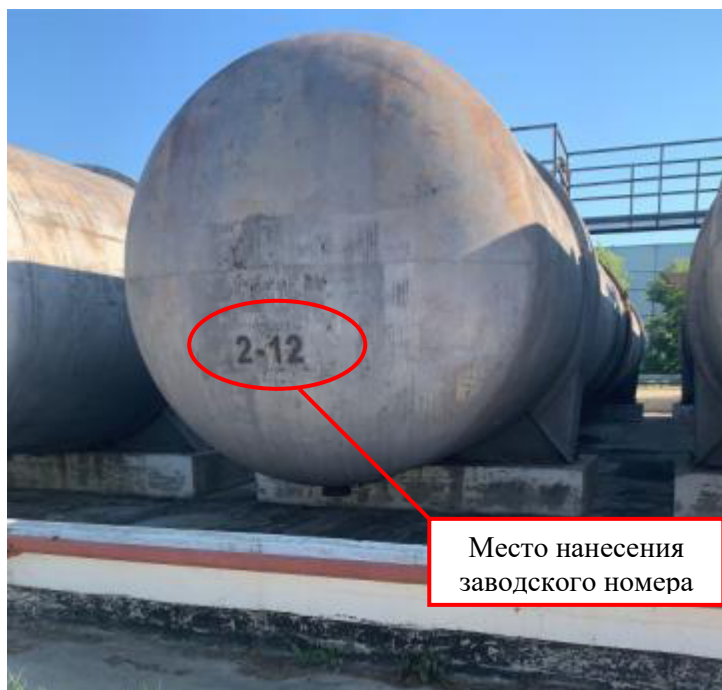
Рисунок 2 – Общий вид резервуара РГС-140 № 2-12 с указанием места нанесения заводского номера
