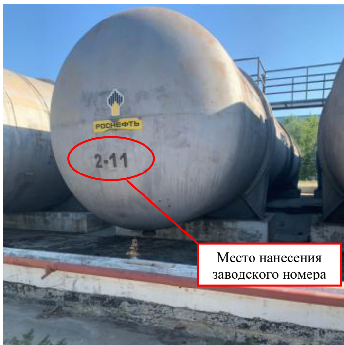
Рисунок 1 – Общий вид резервуара РГС-140 № 2-11 с указанием места нанесения заводского номера
