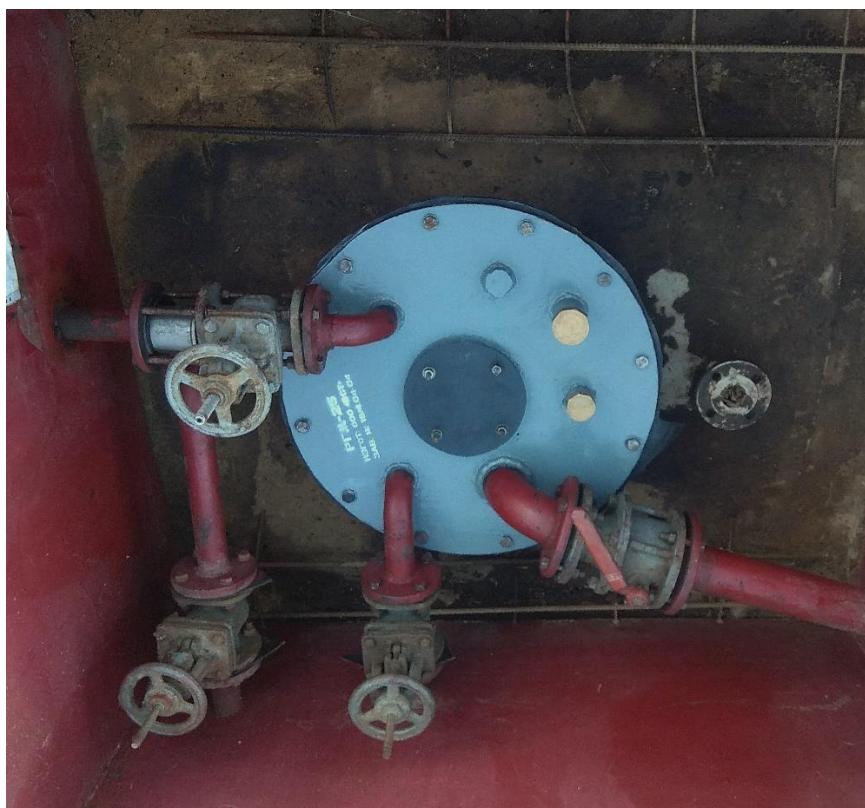
Рисунок 2 - Фотография горловины и крышки замерного люка резервуара
