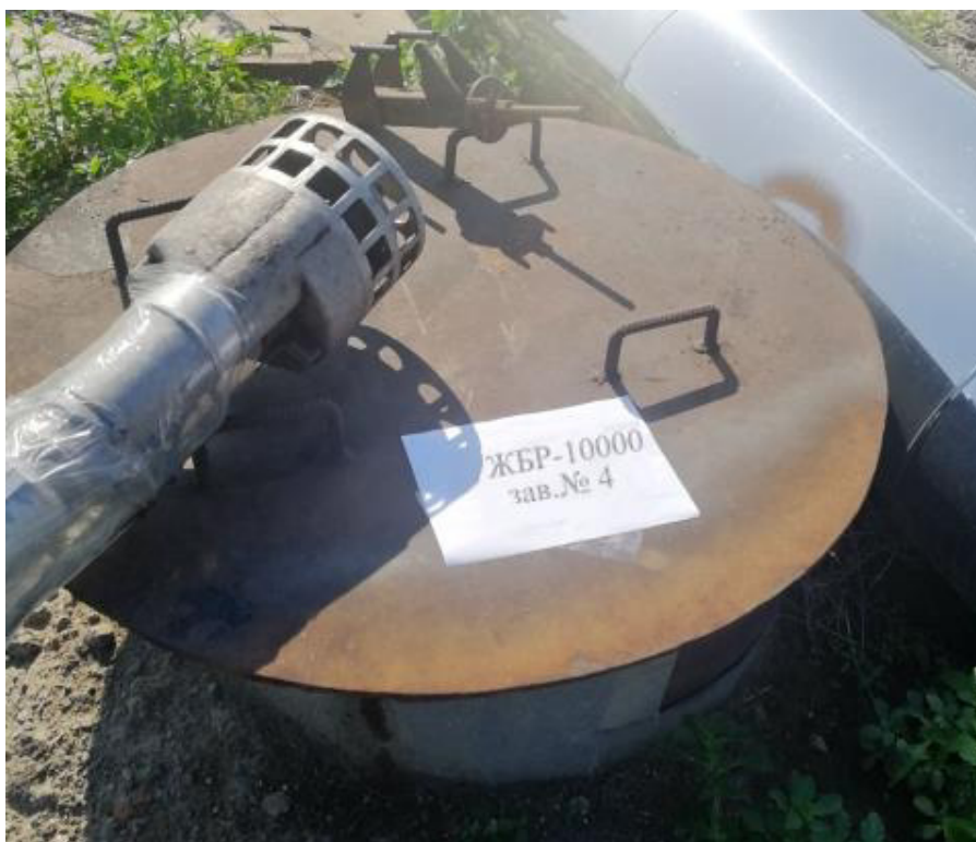
Рисунок 2 – Горловина резервуара ЖБР-10000 № 4 Пломбирование резервуара ЖБР-10000 не предусмотрено.
